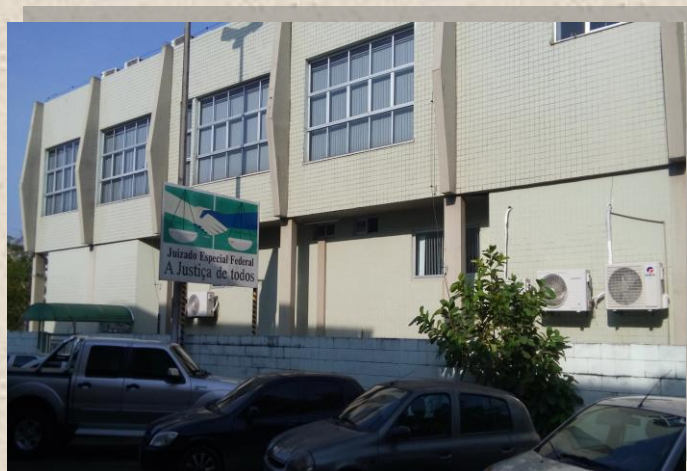
Figura 7 — Edifício Rio Solimões
